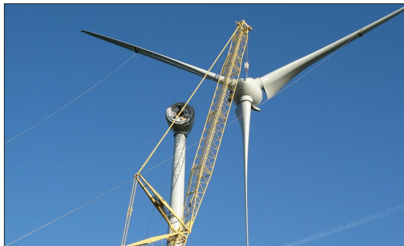
Photo 1 : Opération de levage du rotor d'une éolienne 2MW
