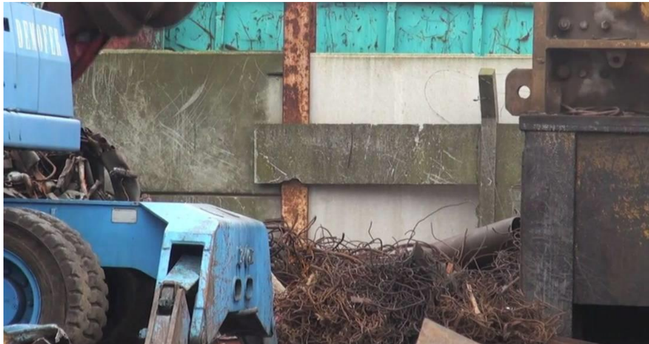
Photo 15: Evacuation des éléments démantelés (1)
