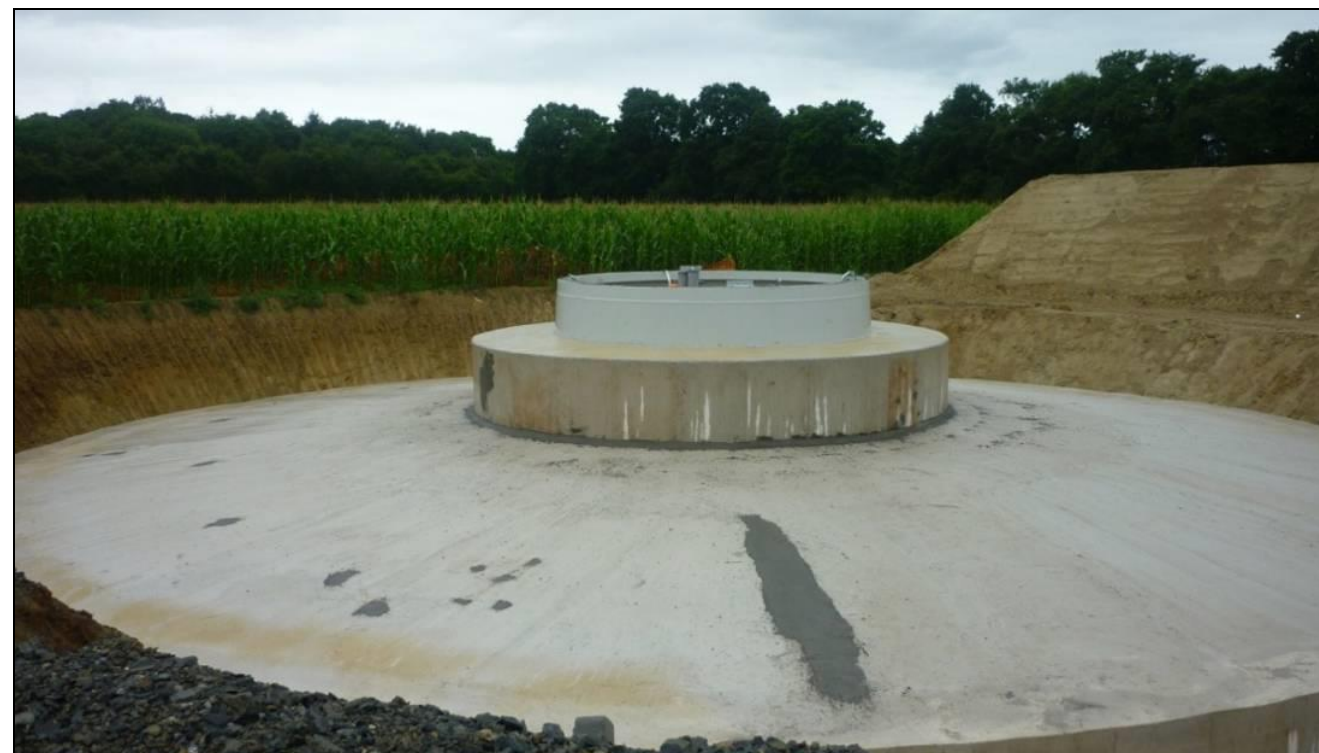
Photo 9 : Etape de bétonnage
