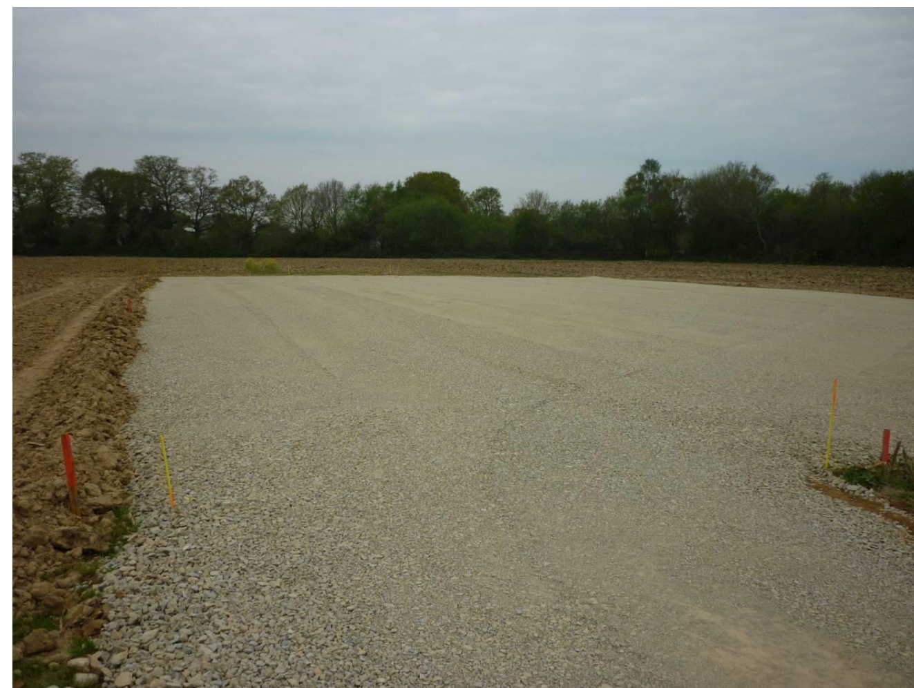
Photo 18 : Exemple de plateforme construite
