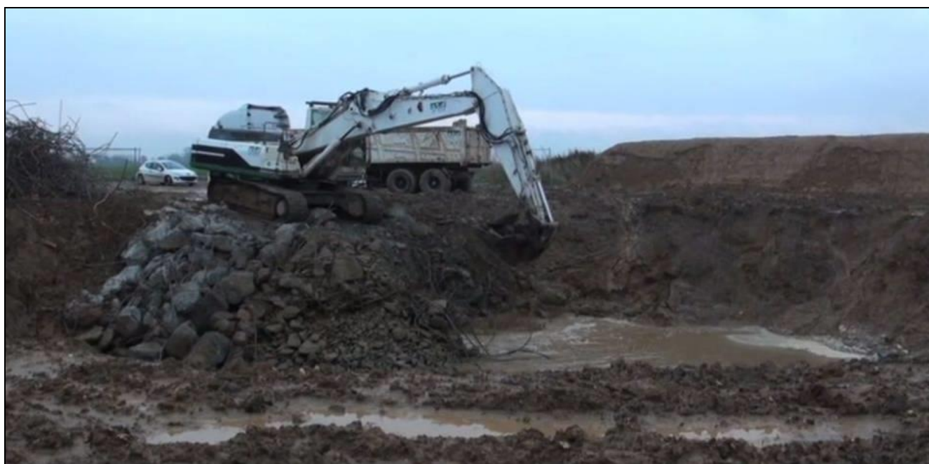
Photo 12: Evacuation des débris
