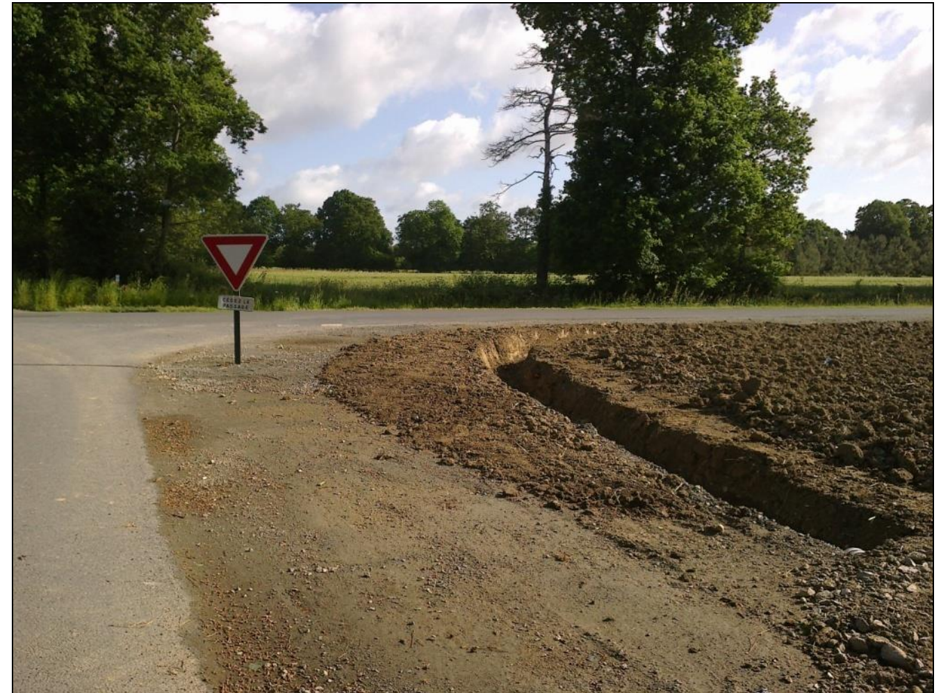
Photo 6: Exemple d'aménagement remis en état
