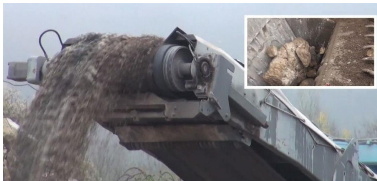
Photo 14: Concassage du béton des fondations
