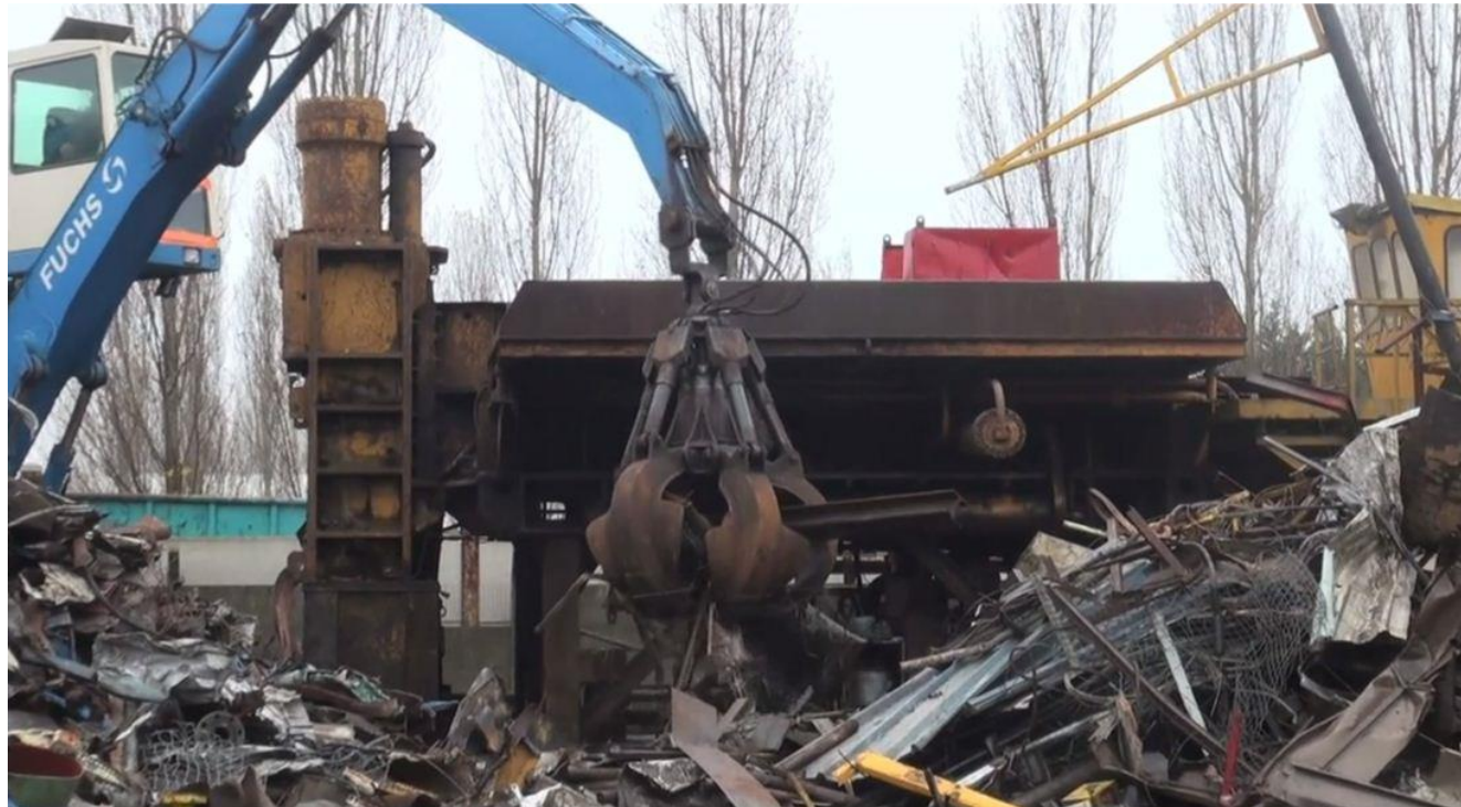
Photo 16: Evacuation des éléments démantelés (2)
