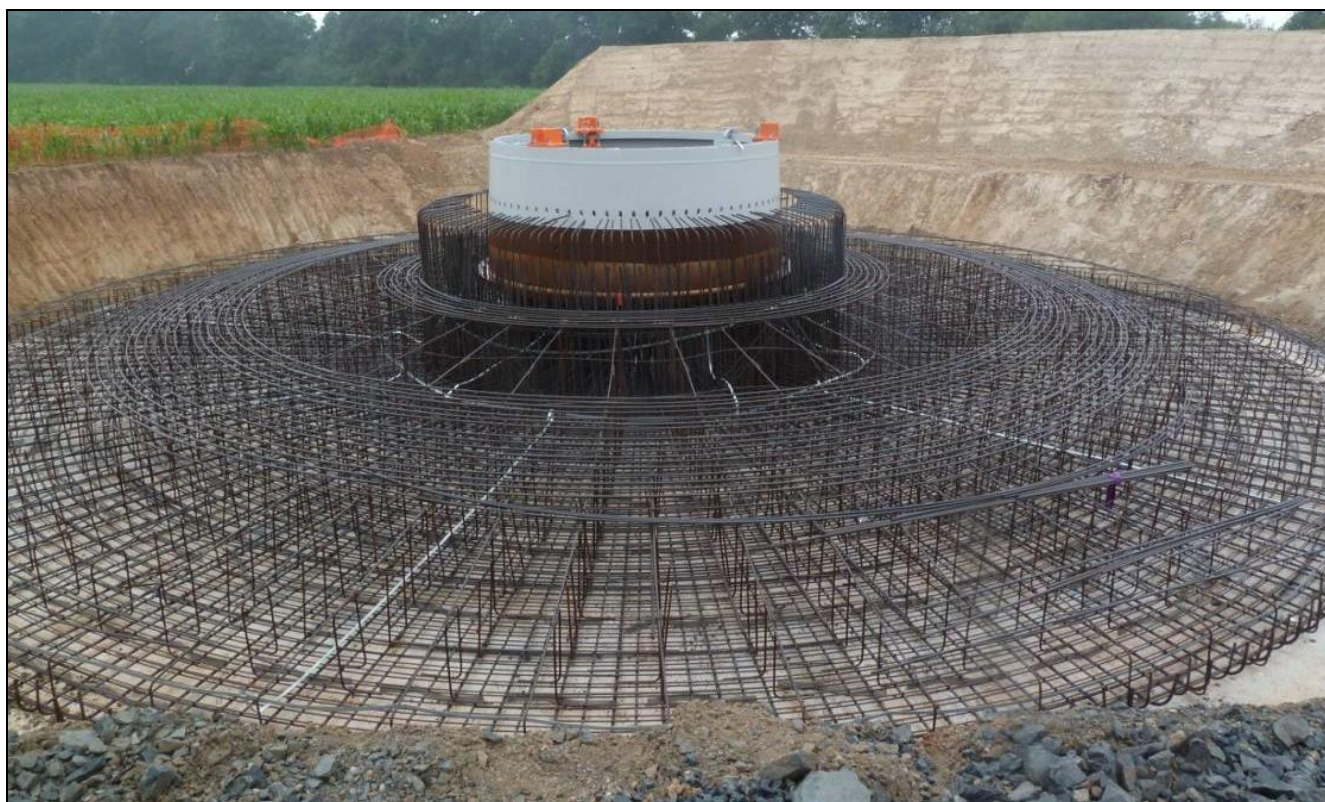
Photo 8 : Etape de Ferrailage
