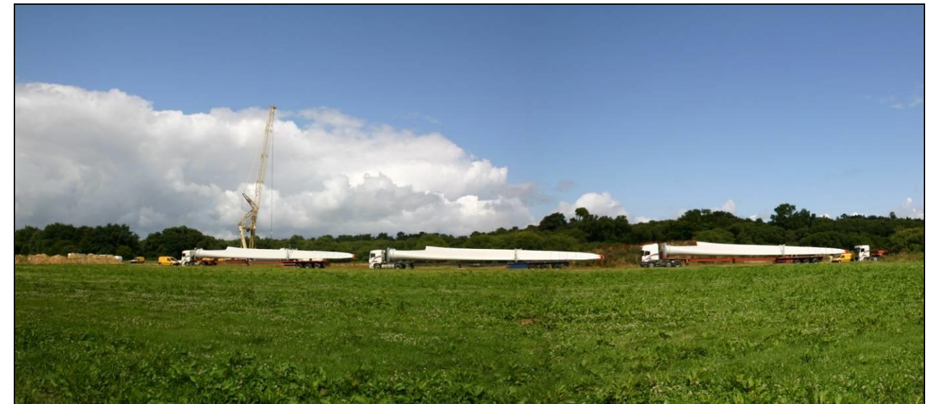
Photo 4 : Arrivée des pales sur site
