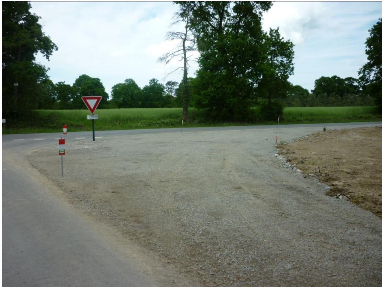
Photo 5: Exemple d'aménagement pendant le chantier
