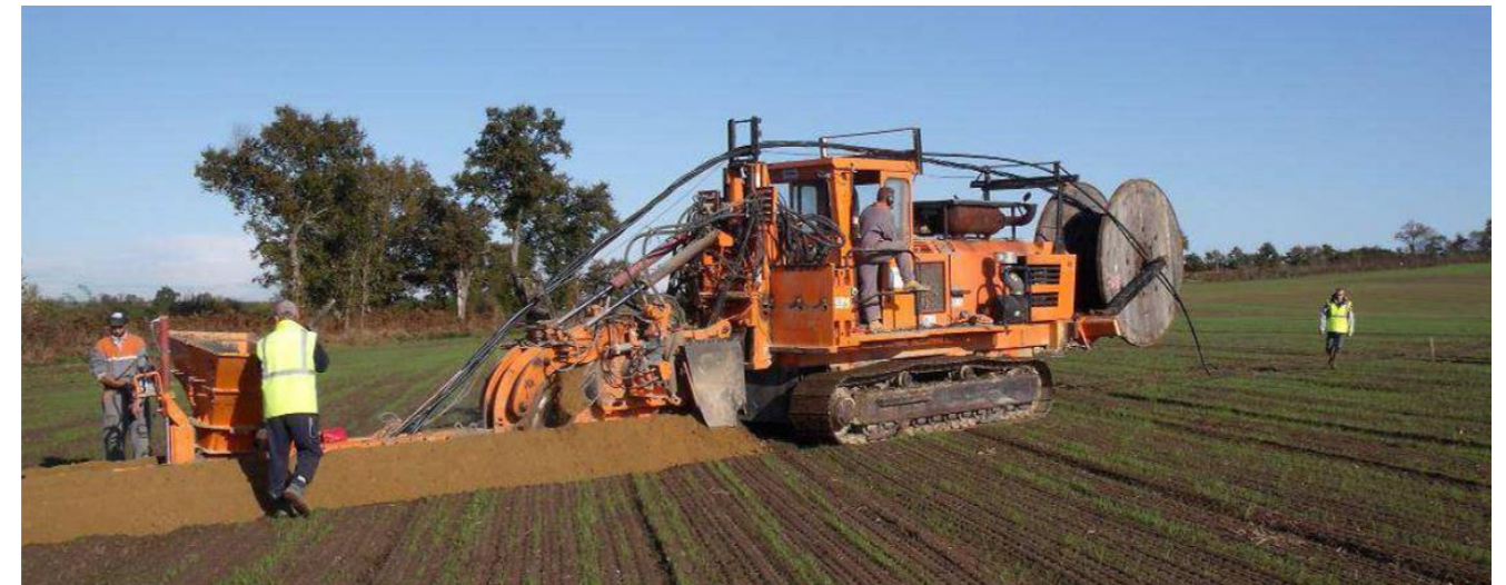
Photo 3 : Pose de câble par trancheuse sur une parcelle privée
