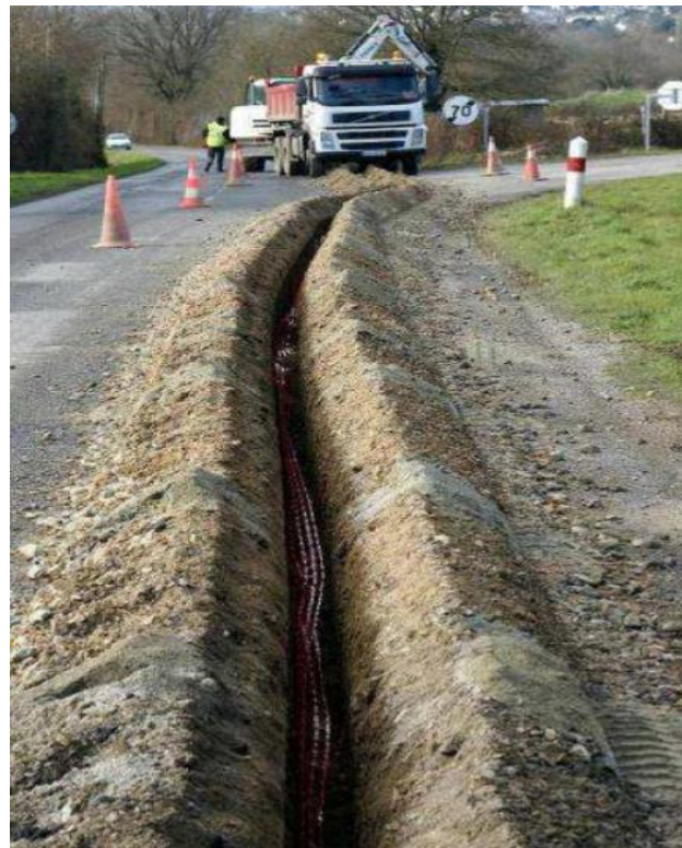
Photo 20: Réalisation d'une tranchée en domaine public
