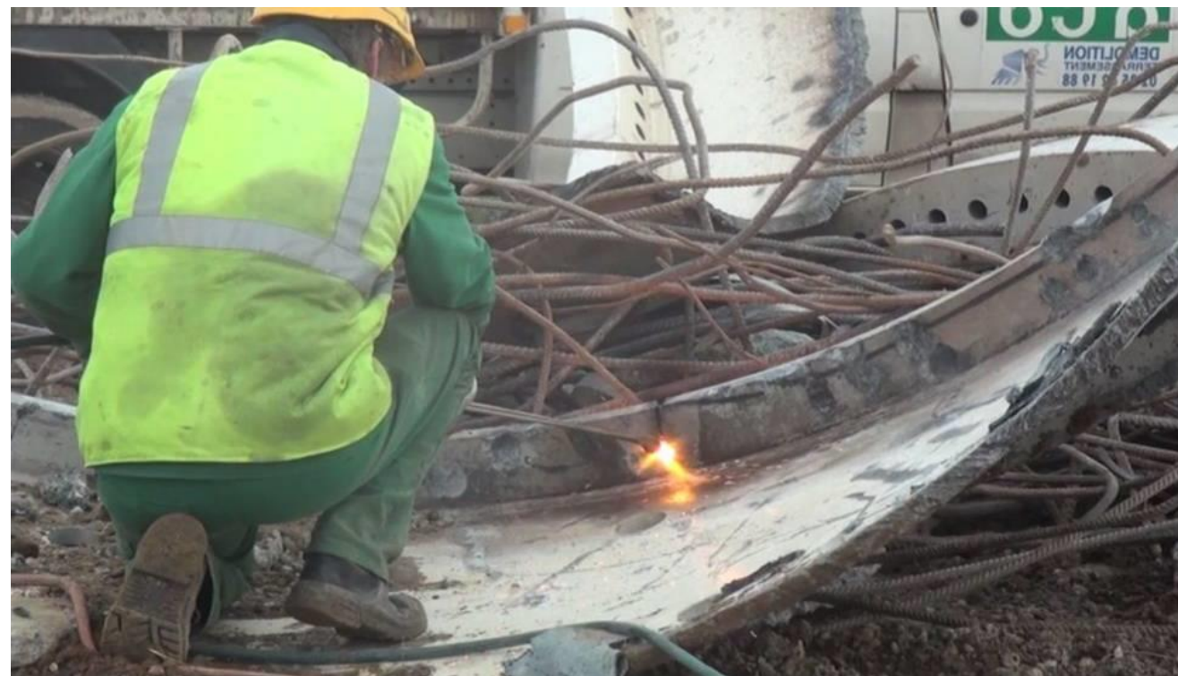
Photo 13 : Tri et découpage au chalumeau d'acier
