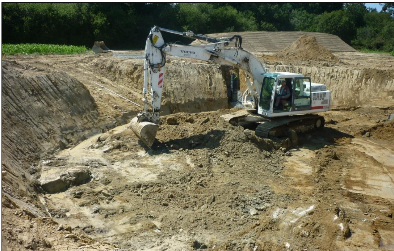
Photo 7 : Excavation de la terre
